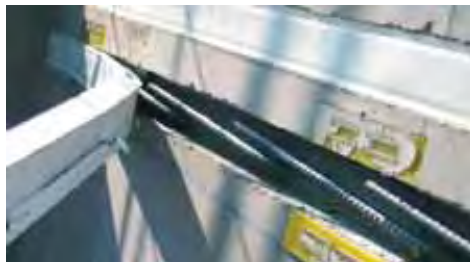
Boîte d'attente à support amovible. Dégagement des armatures.
