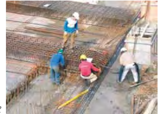
Pose d'armature sur chantier.
